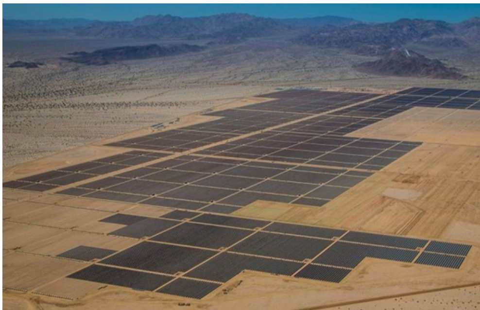
Figura 10 – Vista da usina de geração fotovoltaica Desert Sunlight Farm, Califórnia, USA, de 550 MWp 12 .
