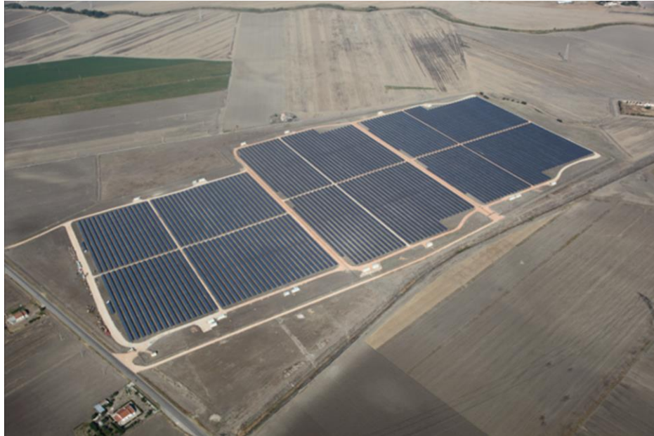
Figura 13 – Vista da UFV Ituverava, Bahia, Brasil, com capacidade de 254 MWp (13)
