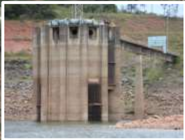
Captação - Tnel 7 30 metros altura
